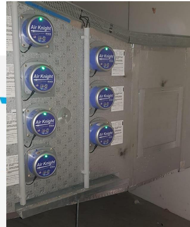
Los módulos se pueden instalar en cualquier sistema HVAC, en el plenum o encima de la unidad de ventilación.
